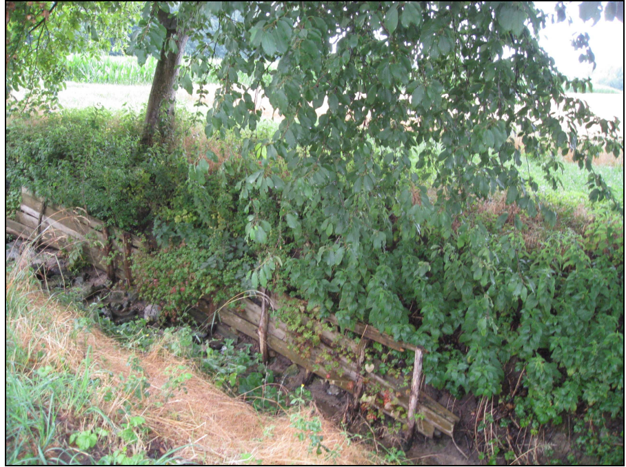
Abbildung 2: Dörrbachgraben mit provisorischem Uferverbau
