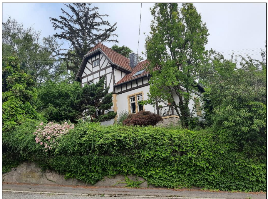
Foto 1: Das denkmalgeschützte Gebäude im Süden des Geländes wird erhalten bleiben, ebenso die Gehölze und der Garten ringsum.
