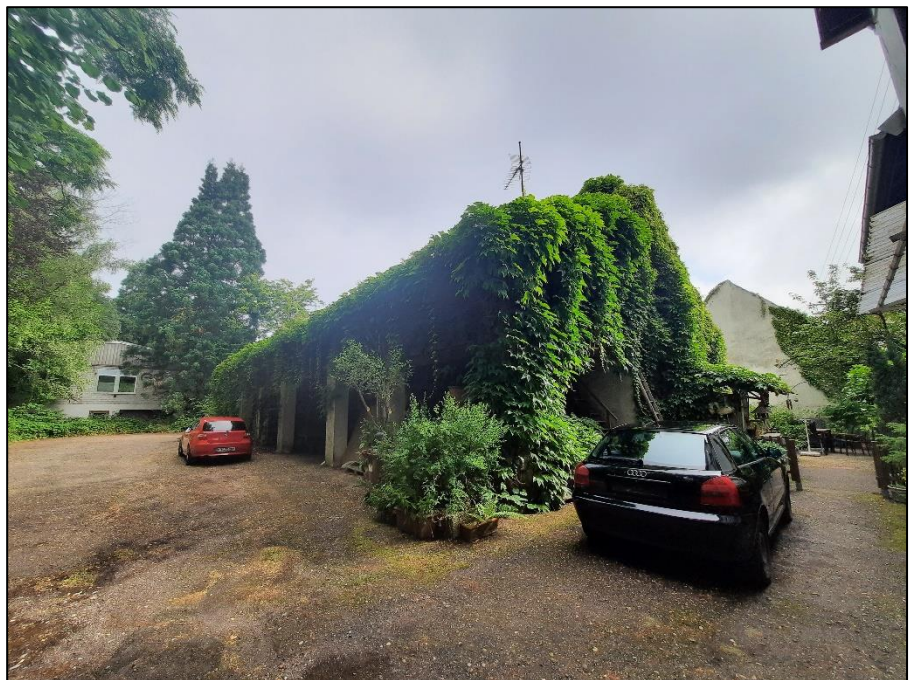
Foto 7: Die Scheune direkt nördlich vom denkmal- geschützten Wohnhaus soll abgebrochen wer- den.
