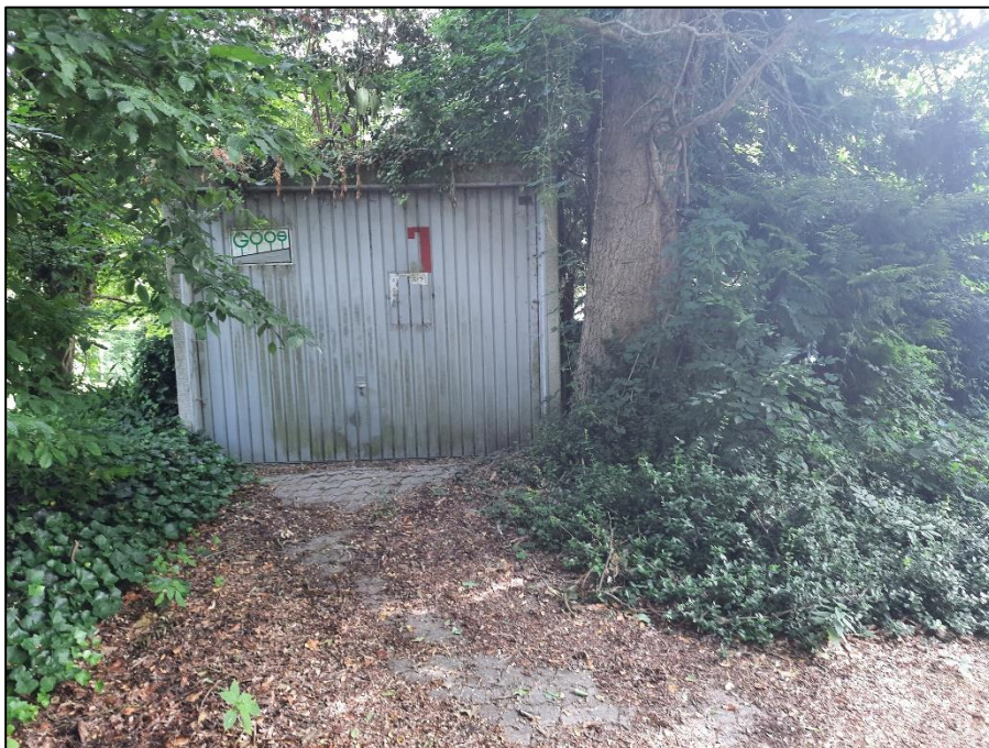
Foto 18: Diese Einzelgarage am nördlichen Ende soll ebenfalls abgebrochen werden.
