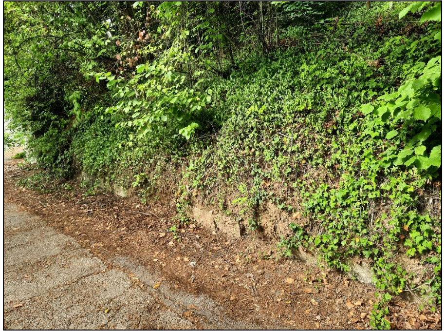
Foto 6: Die Böschung seitlich des Asphaltwegs ist ca. 60 m lang und wird morgens/vormittags am stärksten von der Sonne beschienen.
